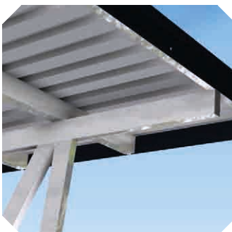
Trapezblech als wasserführendes Unterdach
